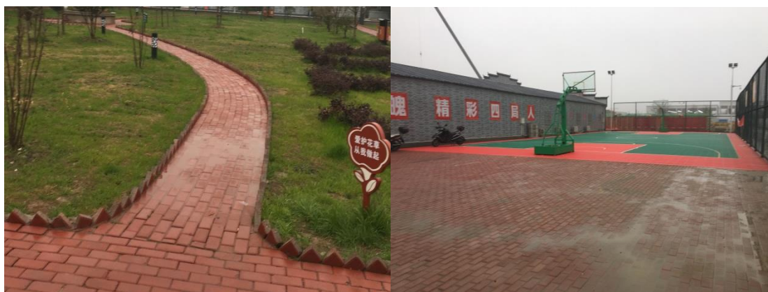
图 1.3-3 铺设透水砖现状
