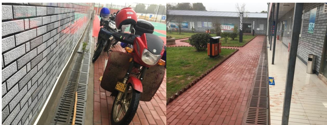
图 1.3-2 排水沉沙设施现状
