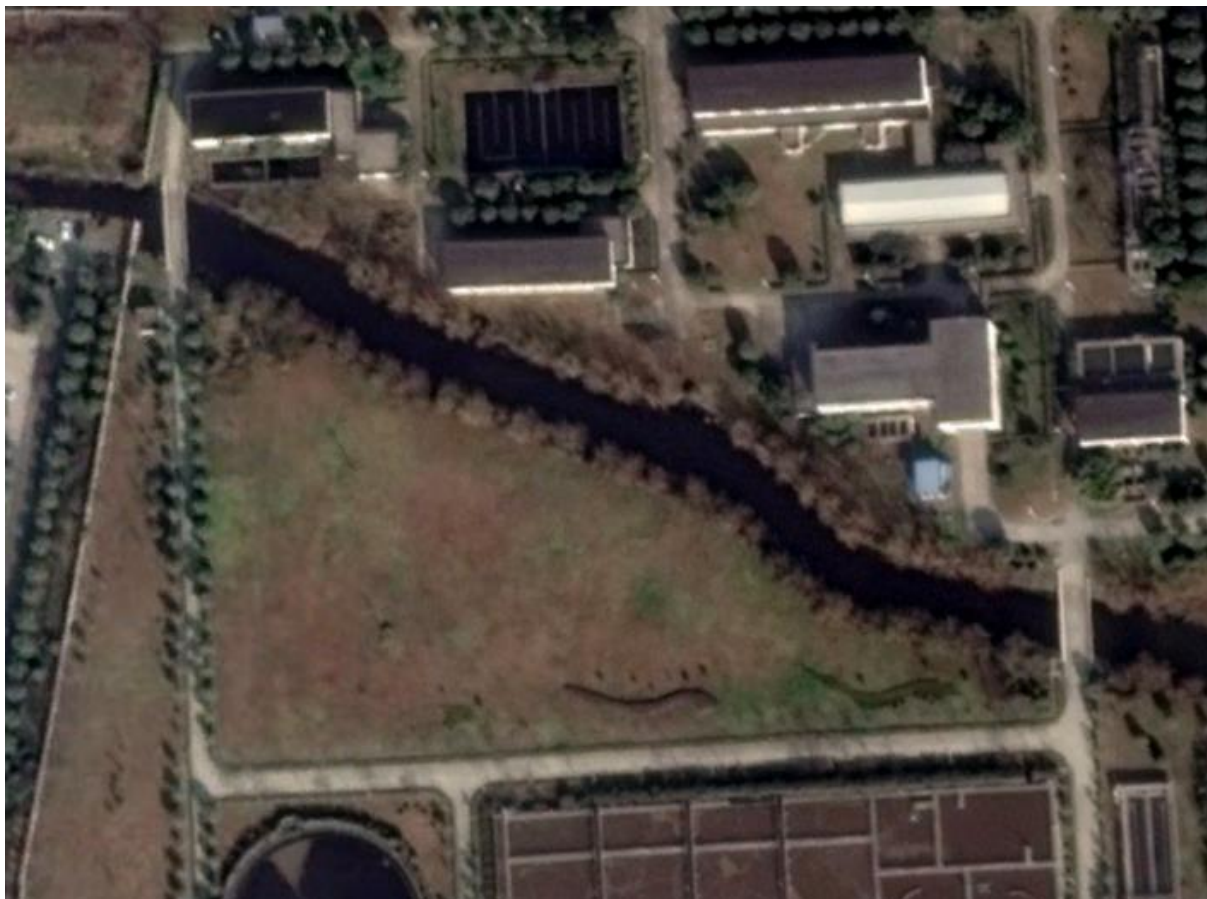
(1)2017/1/16, 建设场地原状
